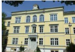
Hauptgebäude, Straße des Friedens
